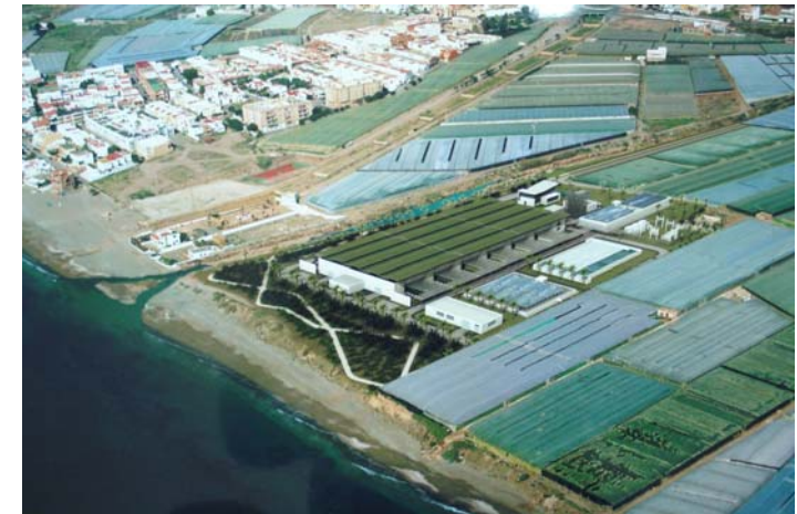
Proyecto Desaladora del Campo de Dalías.
